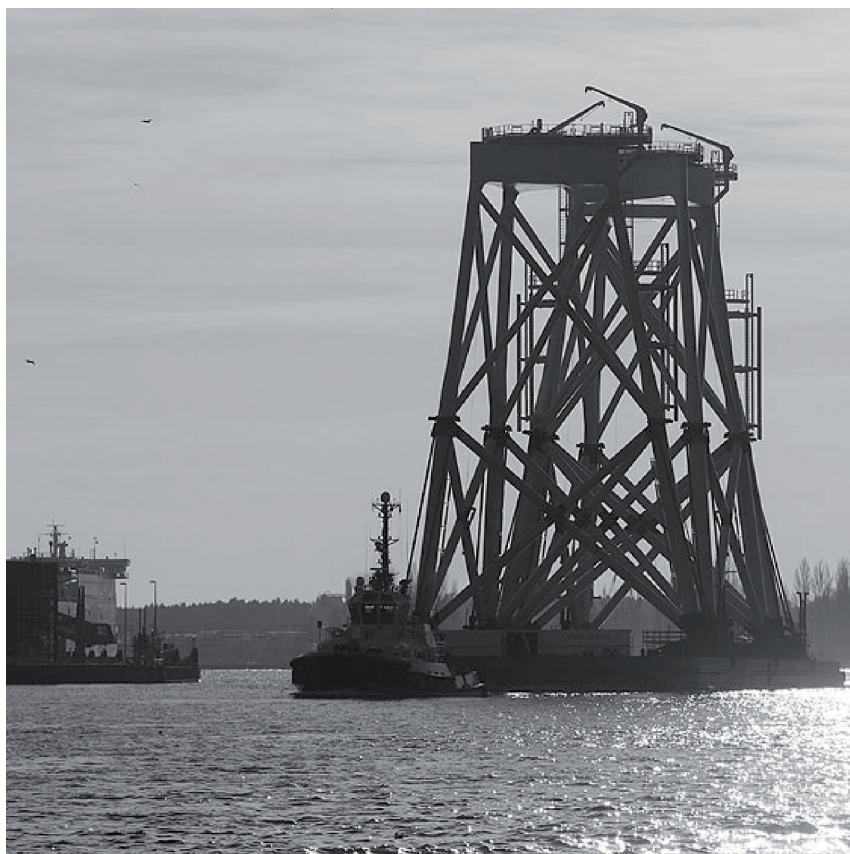
Rysunek 7. Transport kratownicy na barce – kanał na rzece Świna w okolicach Świnoujścia
